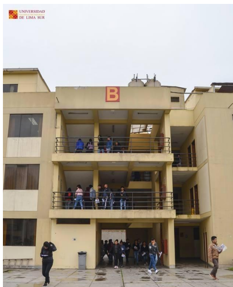
Figura 3: Escaleras de la Universidad Nacional Tecnológica de Lima Sur:
